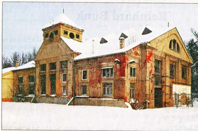
Der Verein will den leeren Teil des Singwitzer Kesselhauses – neben dem Kesselhauslager – als Begegnungsstätte ausbauen. Noch fehlt Geld dafür.
